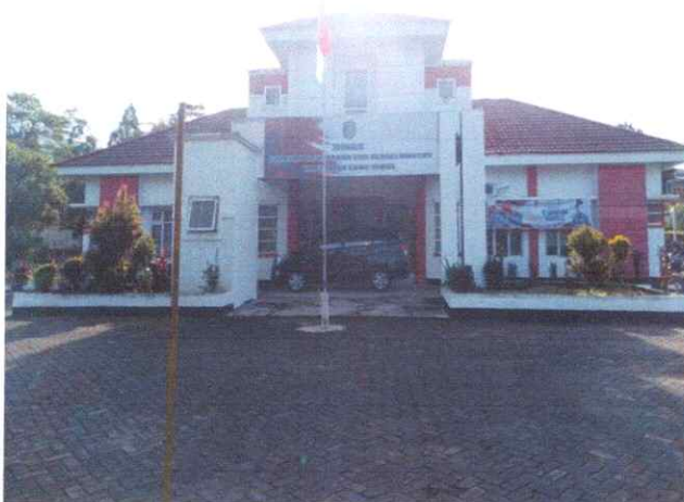
KANTOR DINAS PEMADAM KEBAKARAN
